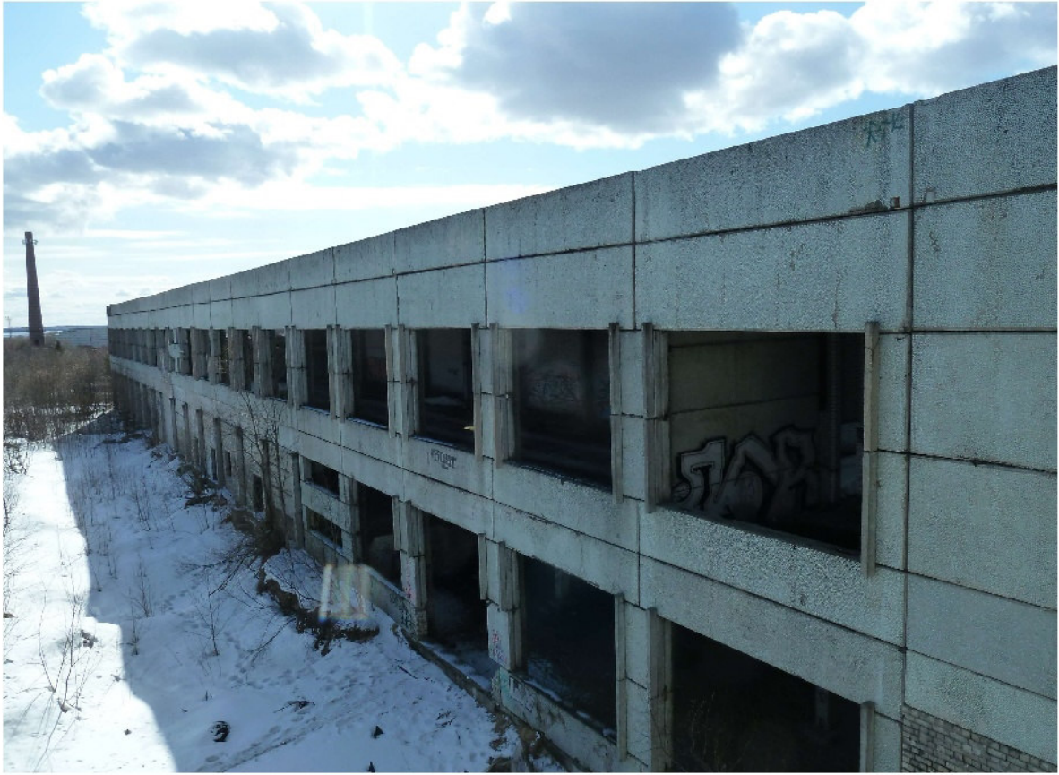
Фото 3. Фасад по оси «Л» в осях "4-25".
