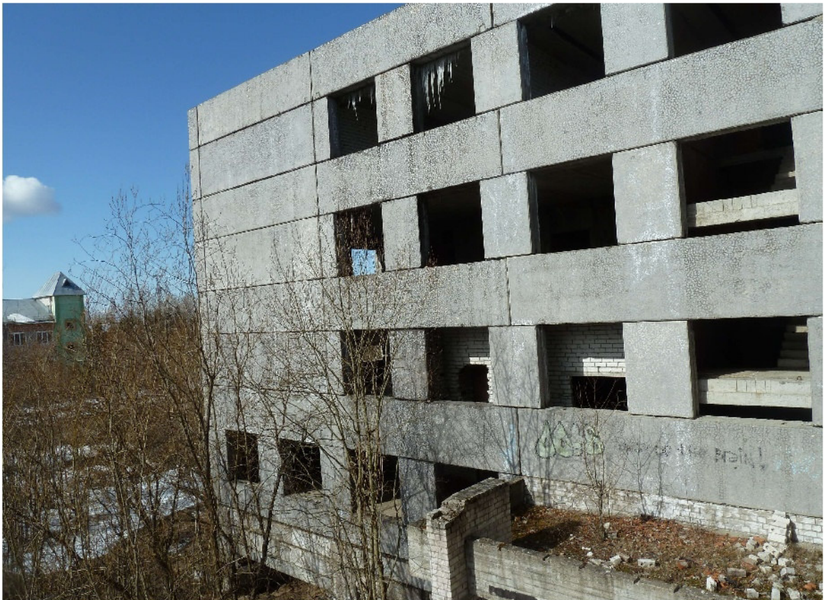
Фото 4. Фасад по оси «5» в осях «А-Г'».
