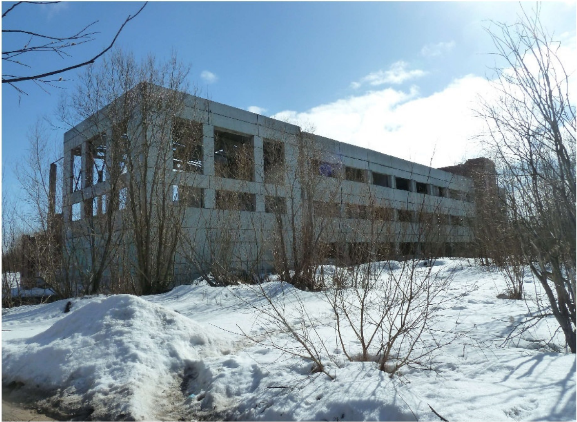
Фото 9. Фасад по оси "1" в осях "С-Г".
