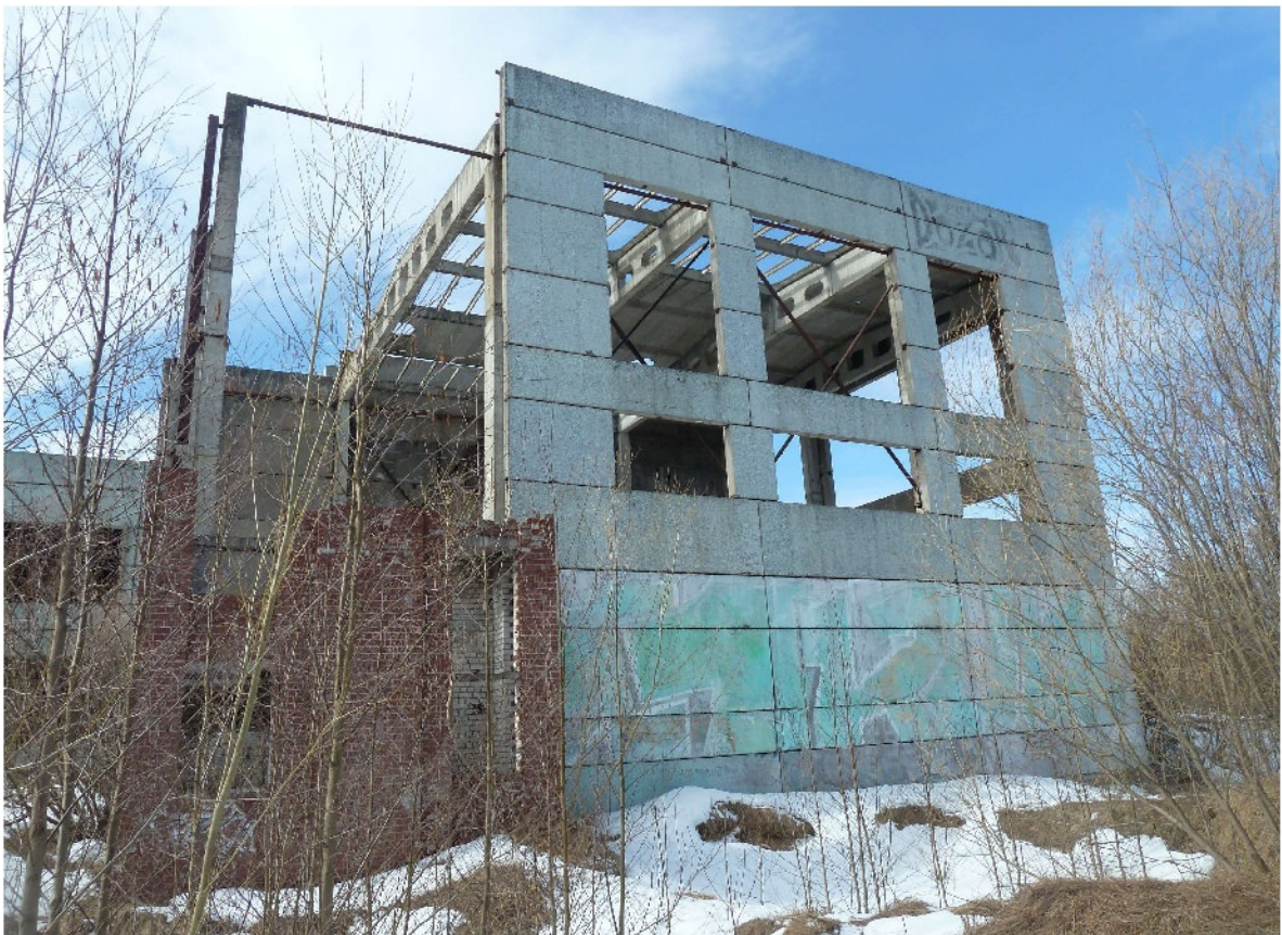
Фото 6. Фасад по оси "С" в осях "1-5".
