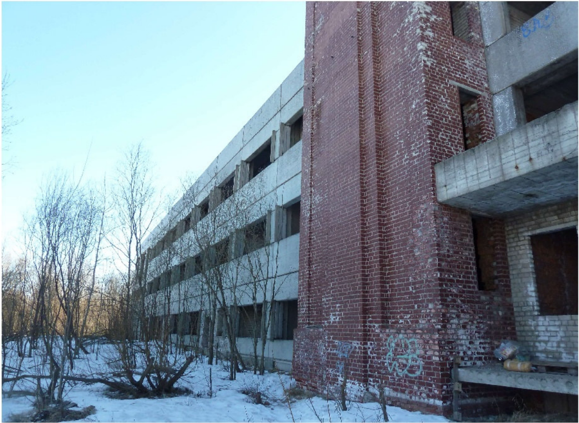
Фото 7. Фасад по оси «1» в осях "Б-Н".
