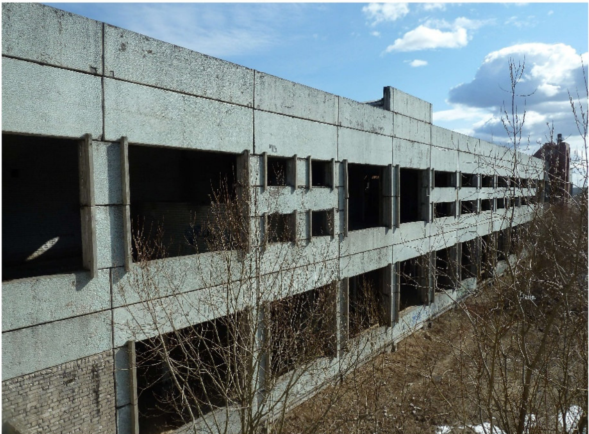
Фото 2. Фасад по оси «Г» в осях "5-25".
