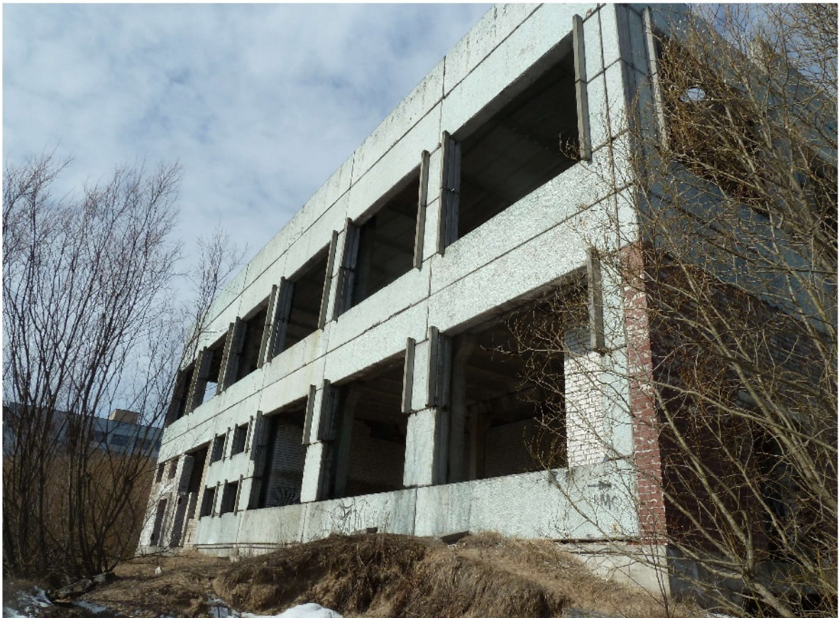
Фото 10. Фасад по оси «25» в осях "Г-Л".
