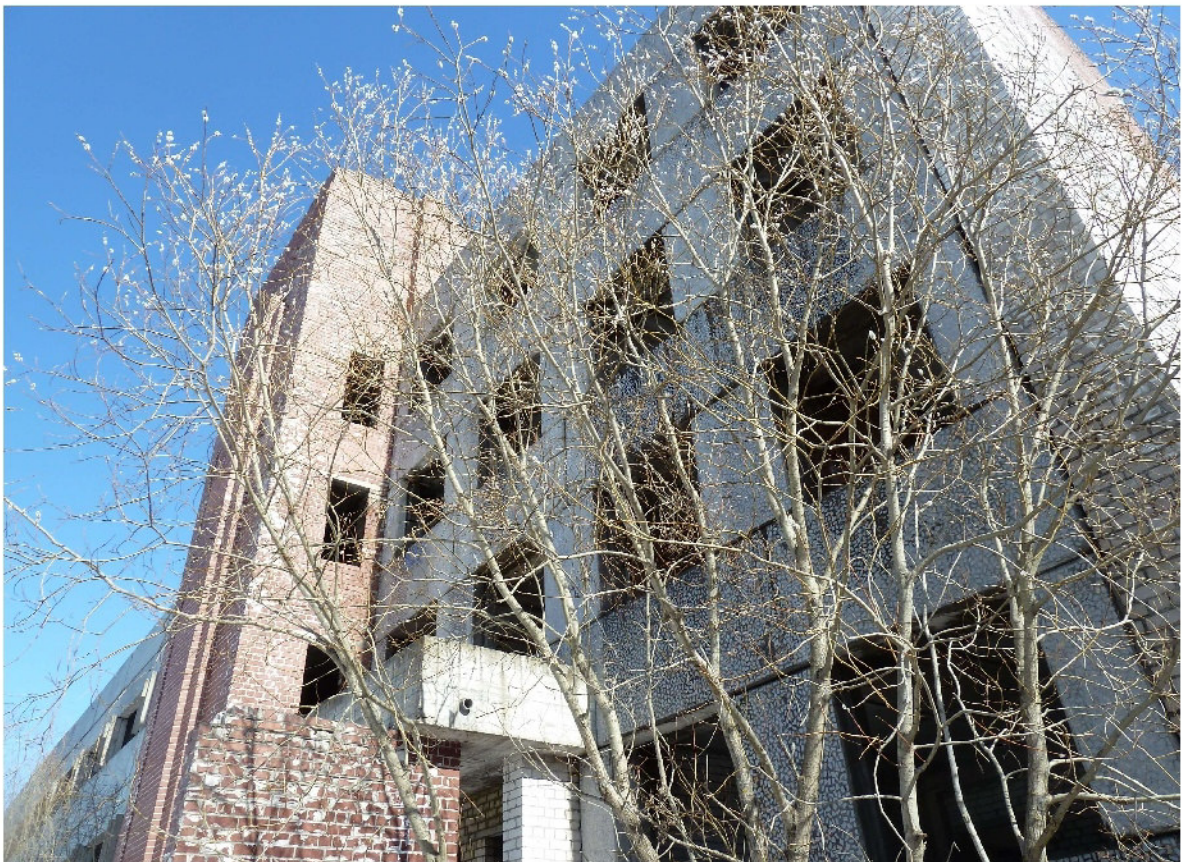
Фото 8. Фасад по оси «1» в осях "А-Г".
